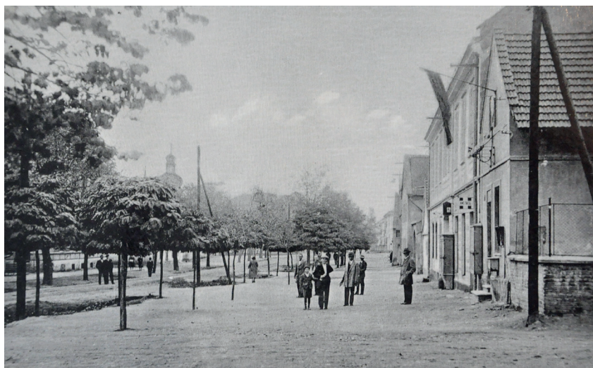
U pošty (střed severní silnice kněžveské)
